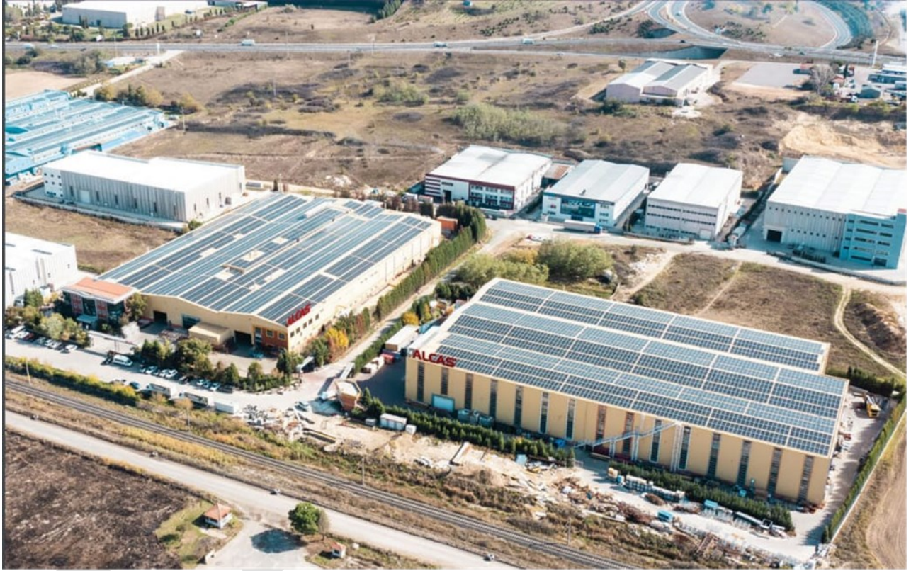
Şirket'in Çorlu/Tekirdağ'da bulunan üretim tesisi
